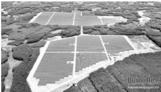
Nhà máy điện mặt trời Bình Nguyên
